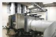
Disjoncteurs de générateur (GCB)
