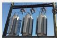
Régulateurs de tension
